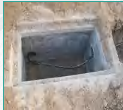
室外PVC管埋地敷设
