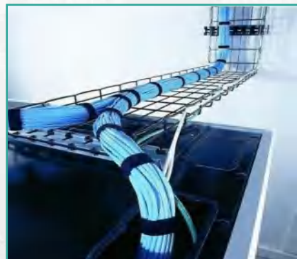
管道吊顶内敷设
