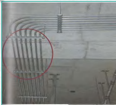
管道墙内切槽敷设
